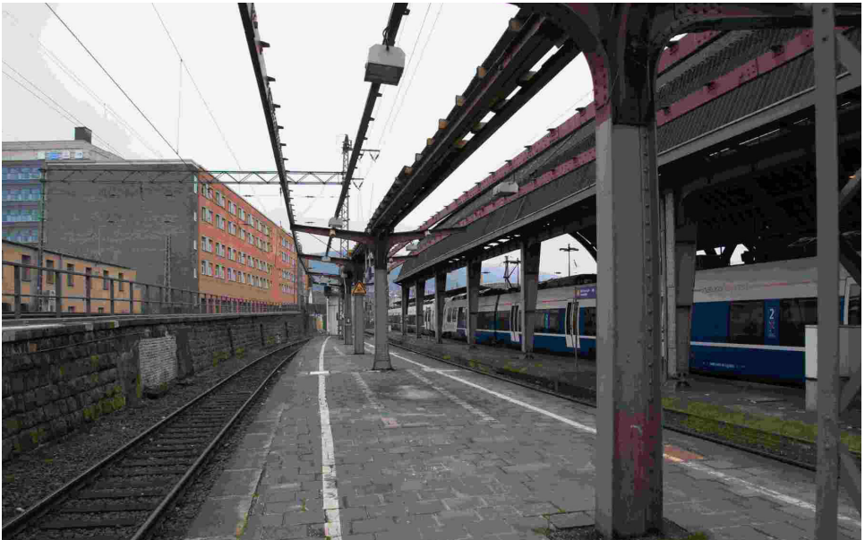
Bahnsteig 1 mit Restbeständen der alten Dachkonstruktion. Foto: Patrick Lausen
